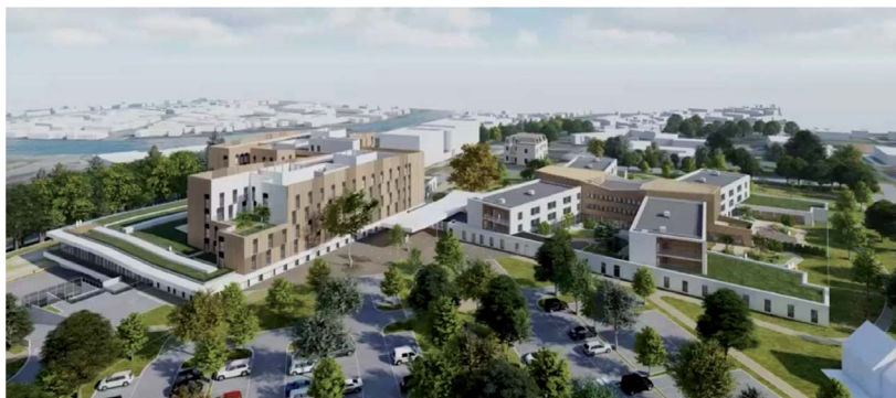
Futur Pôle de Santé d'Orgemont : un partenariat LNA-LRS
